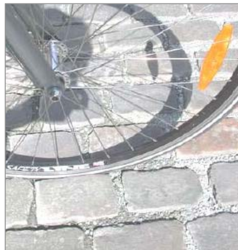
Abb.3.2: Beispiel von breiten und für Fahrräder gefährlichen Fugen
