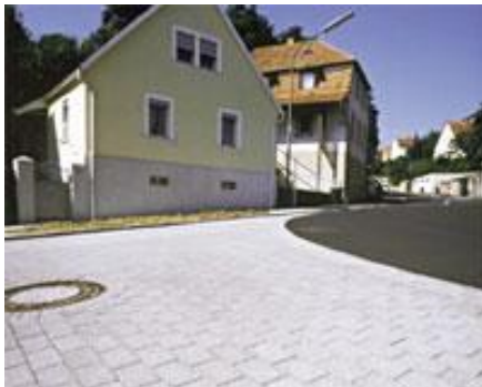
Abb. 3.4. Lärmarme Pflastersteine in Zell bei Würzburg
